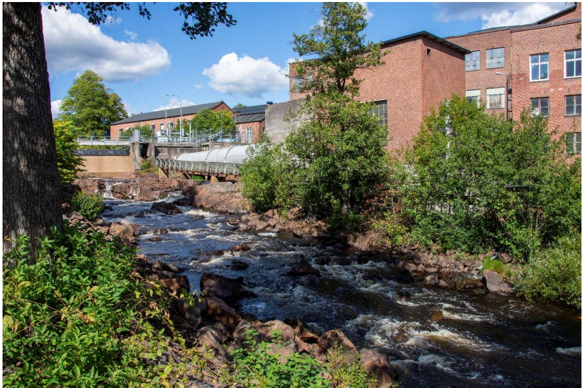
Bild Gyllenfors vattenkraftstation
